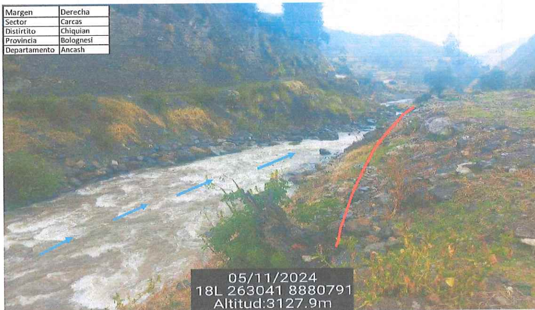
IMAGEN 02. VISTA AGUAS ABAJO DEL PUENTE CARCAS, MARGEN DERECHA PROPUESTA A SER INTERVENIDA, ADYACENTE A UNA VIA DE ACCESO AL PUENTE Y AREAS DE CULTIVO PRESENTA VULNERABILIDAD A EROSION, PRODUCIDA ANTE VENTOS EXTREMOS.
