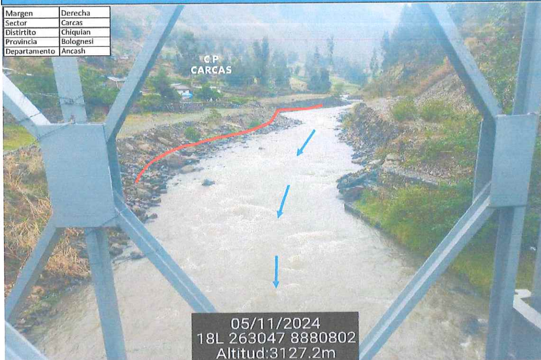
IMAGEN 01. VISTA AGUAS ARRIBA DEL PUENTE CARCAS, MARGEN DERECHA PROPUESTA A INTERVENIR PRESENTA EROSION FLUVIAL, EL CENTRO POBLADO CARCAS UBICADO EN LA MARGEN DERECHA DEL RIO PATIVILCA, VULNERABLE ANTE VENTOS EXTREMOS.
